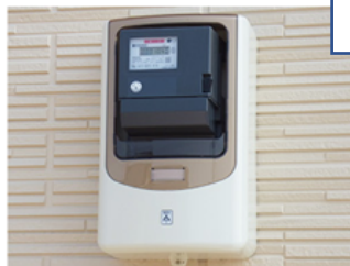
スマートメーター
