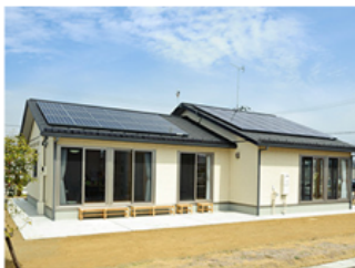
集会所 (防災拠点) ソーラー付 (PV9.1kW)
