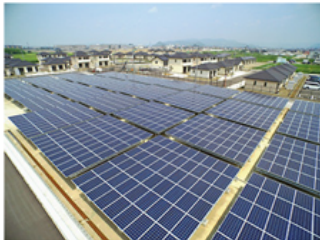
防災調整池ミドルソーラー(400kW)
