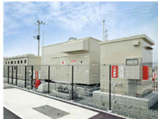
バイオディーゼル非常用発電機 (500kVA)
