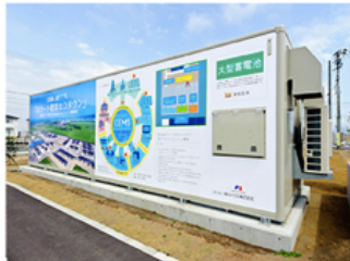
大型蓄電池 (480kWh)
